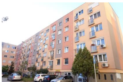
A lakás homlokzata
